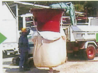
瞬作に土砂をバケツで入れ、吊り上げて移動する
